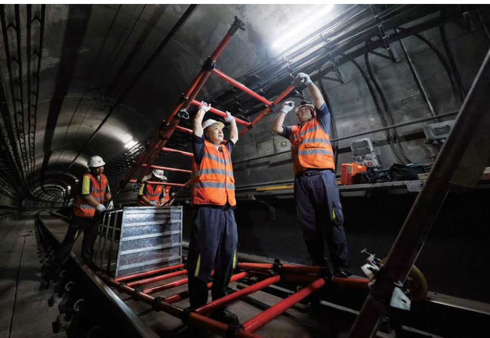
技术人员对北京地铁开展接触网磨耗检测作业。图/中新社
