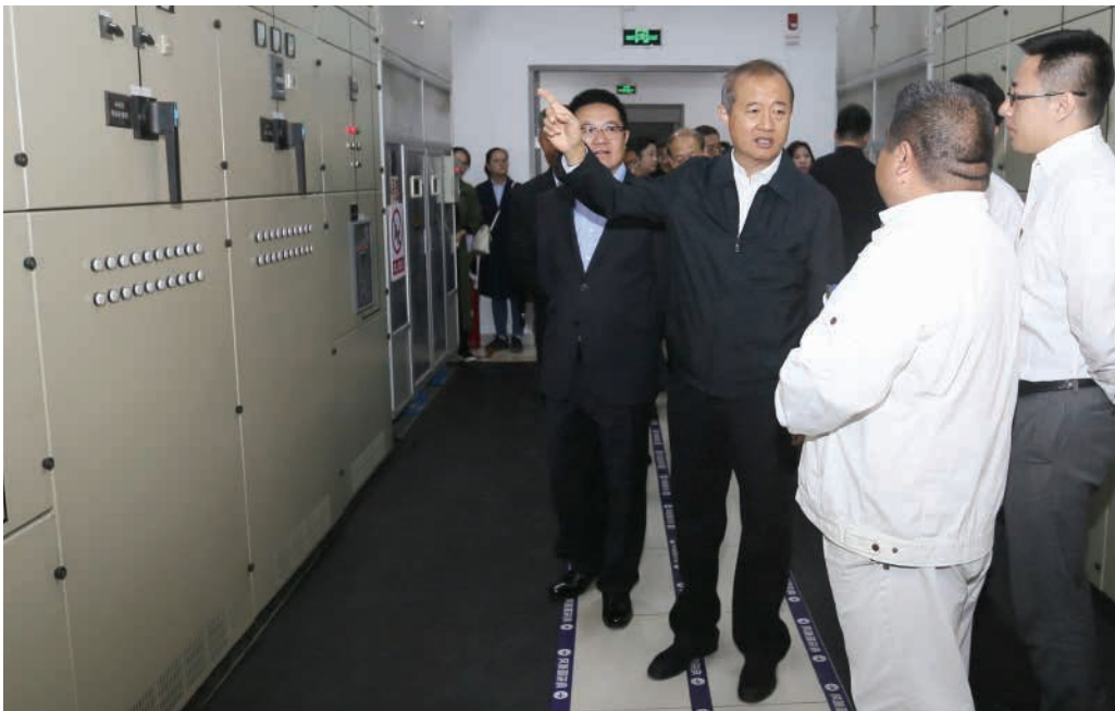
按照市委部署安排，9月29日，市人大常委会主任李伟到朝阳区进行国庆节前检查慰问。图为在朝阳大悦城检查安全生产和消防工作。摄影/薛睿杰
